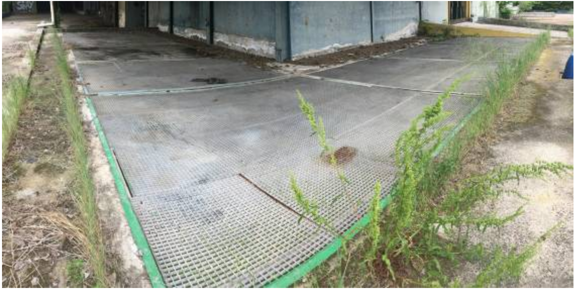
Vasche di raccolta spanti
