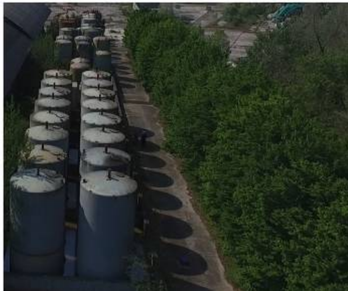
Vista di insieme del parco serbatoi da sud
