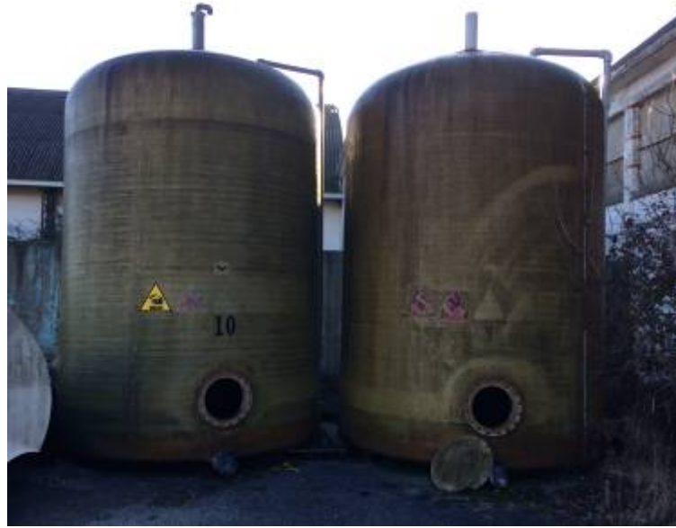
Serbatoi in vetroresina dismessi
