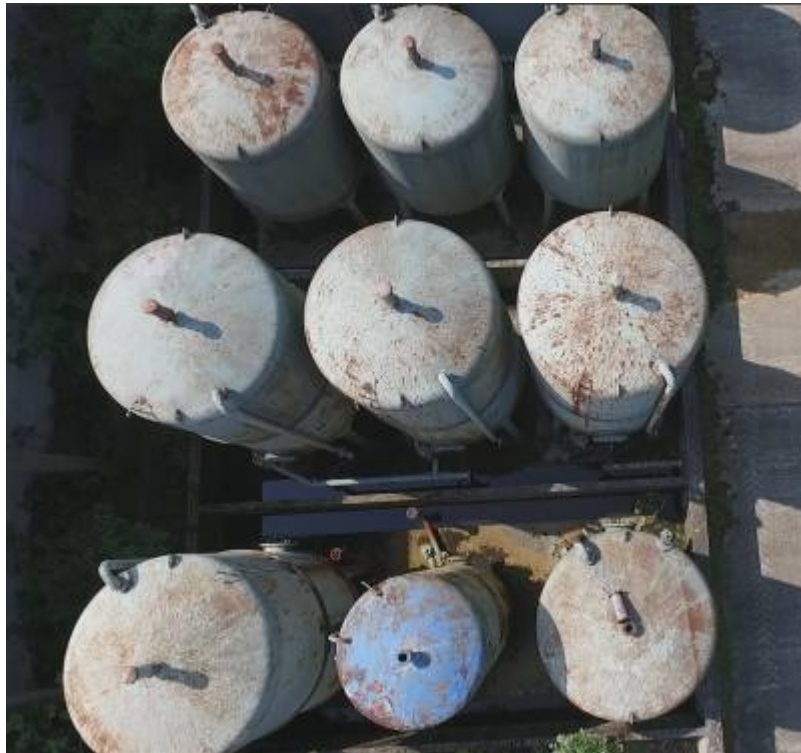
Vista dall'alto dei serbatoi non dotati di passo d'uomo (bacini 41B, 41C e 41D)
