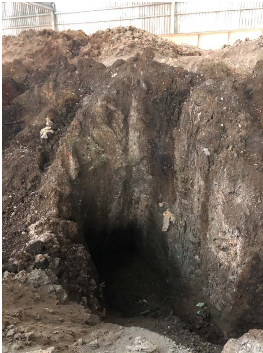
Figura 3 particolare di una sezione sul fronte di scavo di un lotto: nella matrice di colore grigia emergono elementi di vario colore
