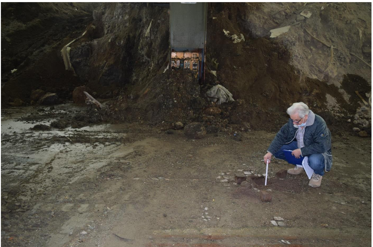
FOTO 8: rilievo spessore sampietrini e letto di posa in sabbia – posizione “A”
