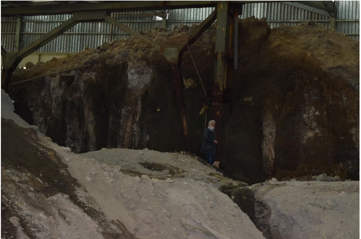
FOTO 7: rilievo pilastro “6” lato interno (Nord)
