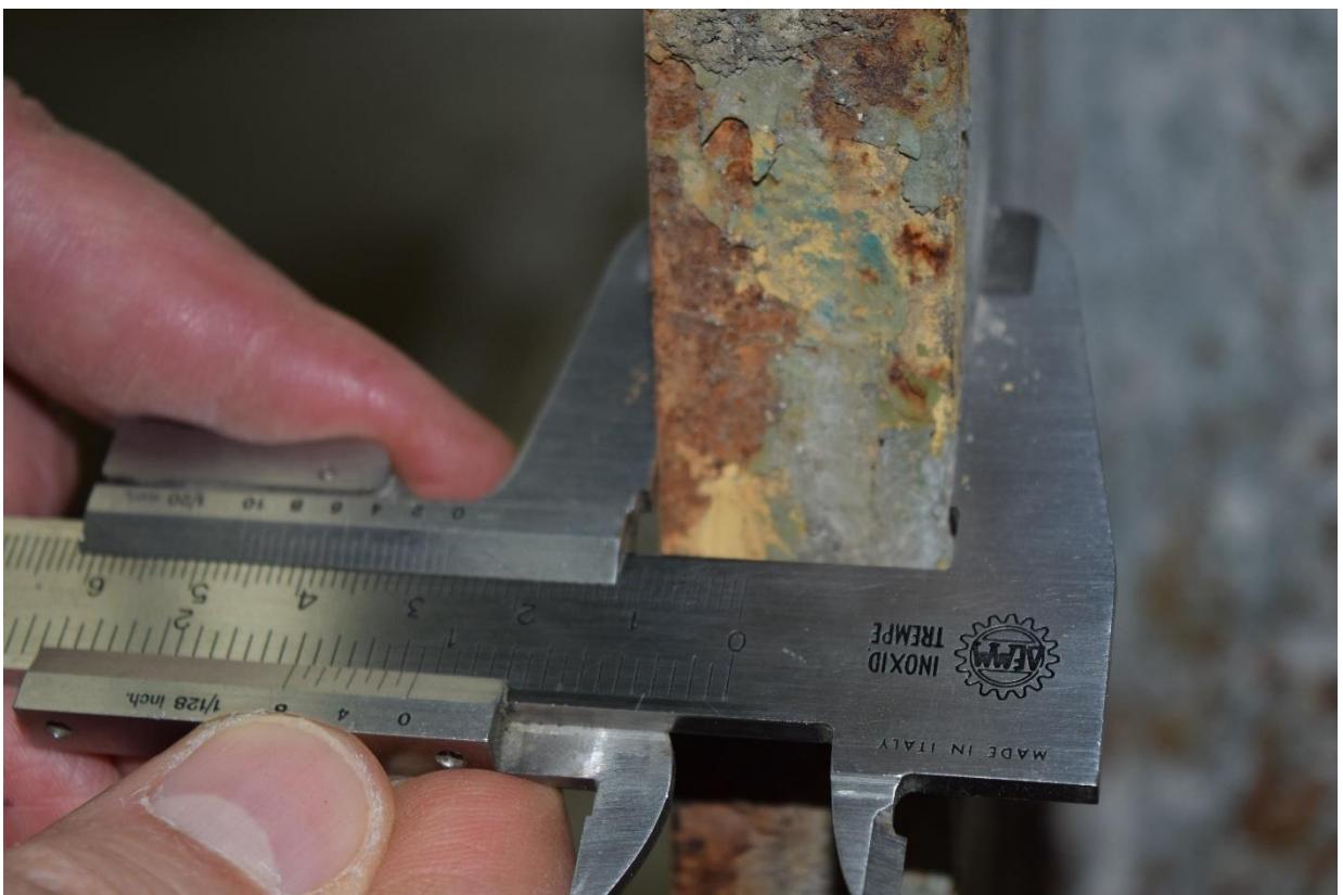
FOTO 2: misura spessore ala pilastro "1"
