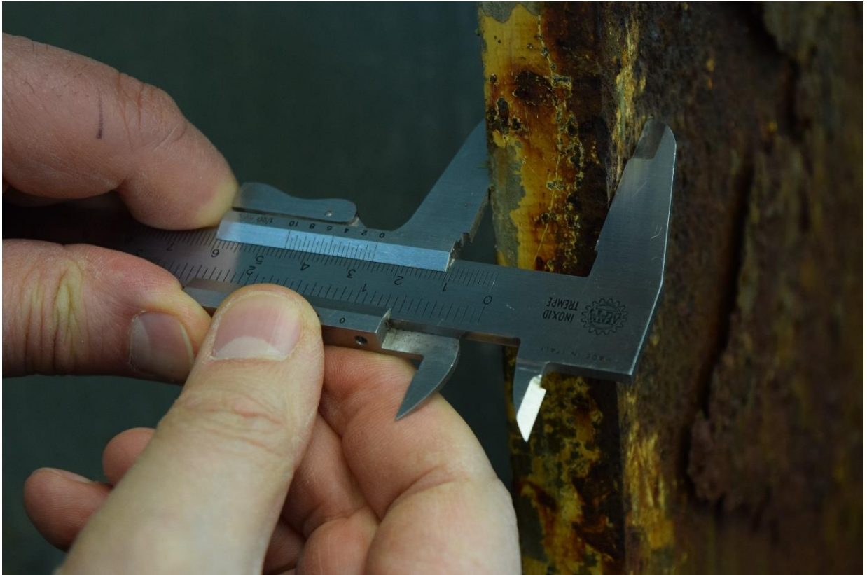
FOTO 5: misura spessore ala pilastro "3"
