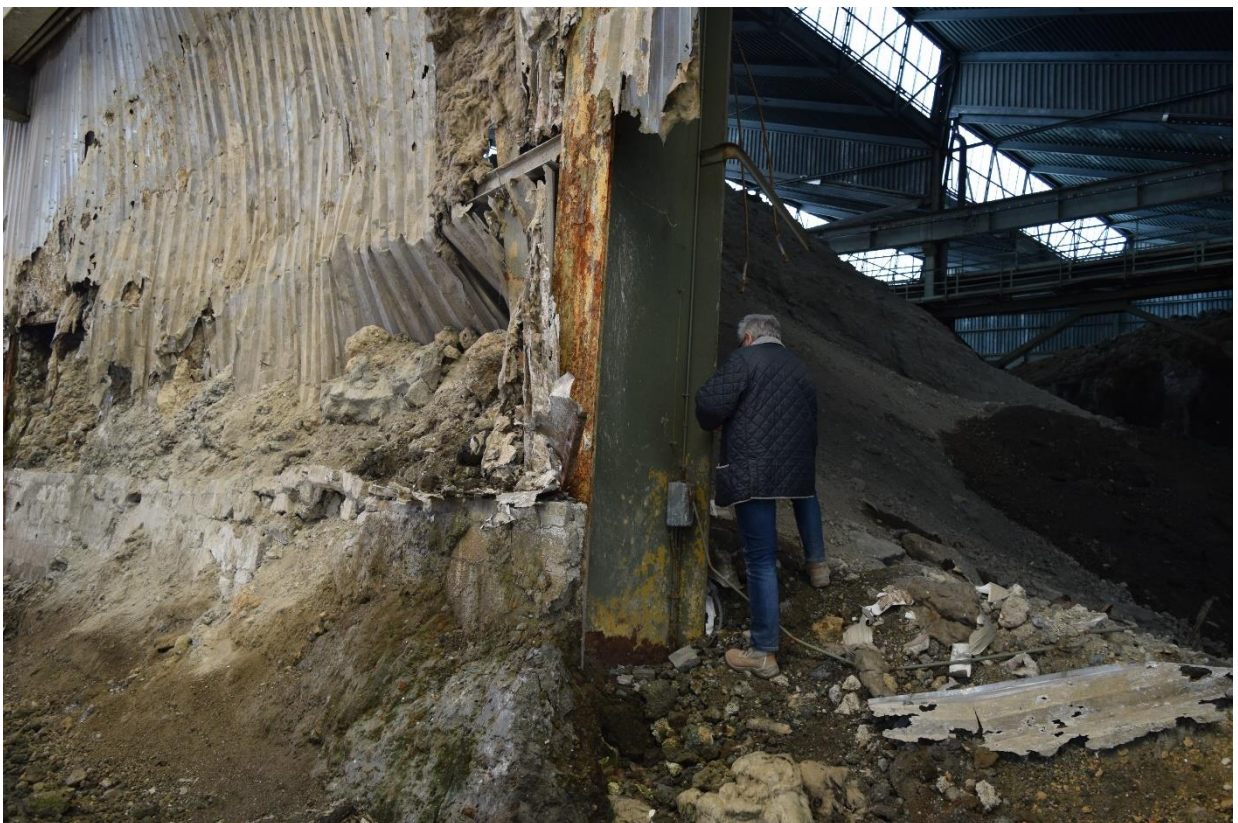
FOTO 6: rilievo pilastro "5" lato Sud
