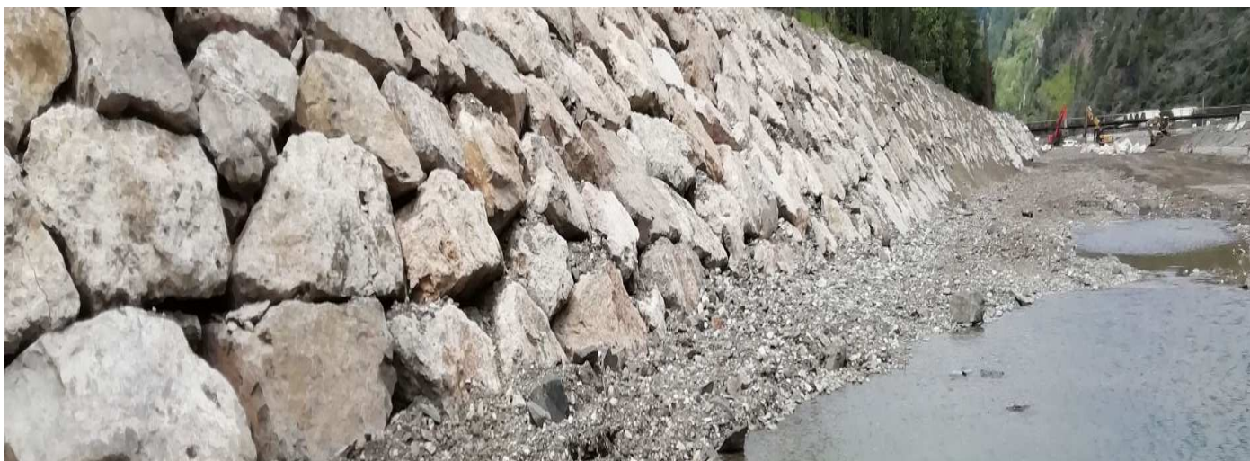
Veduta della massicciata realizzata da Veneto Acque a protezione del Lago di Alleghe (BL)
